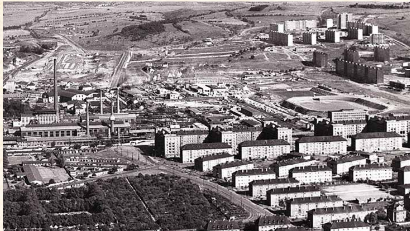
V 60. letech minulého století se v Mostě ve velkém staví nové obytné bloky.
