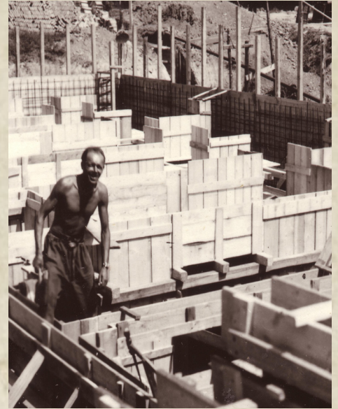
Výstavba zásobníků uhlí v roce 1947.
