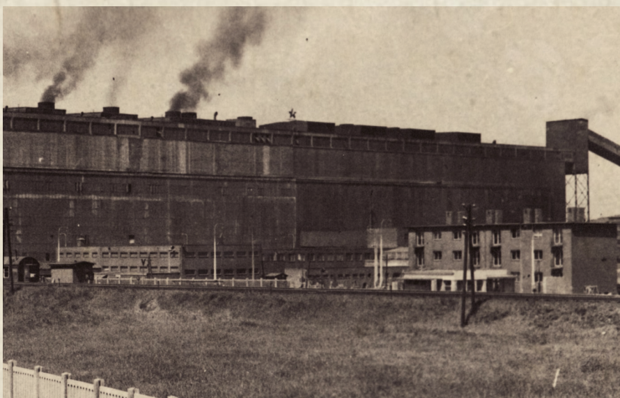
Komořanská elektrárna v době dokončení v roce 1959.
