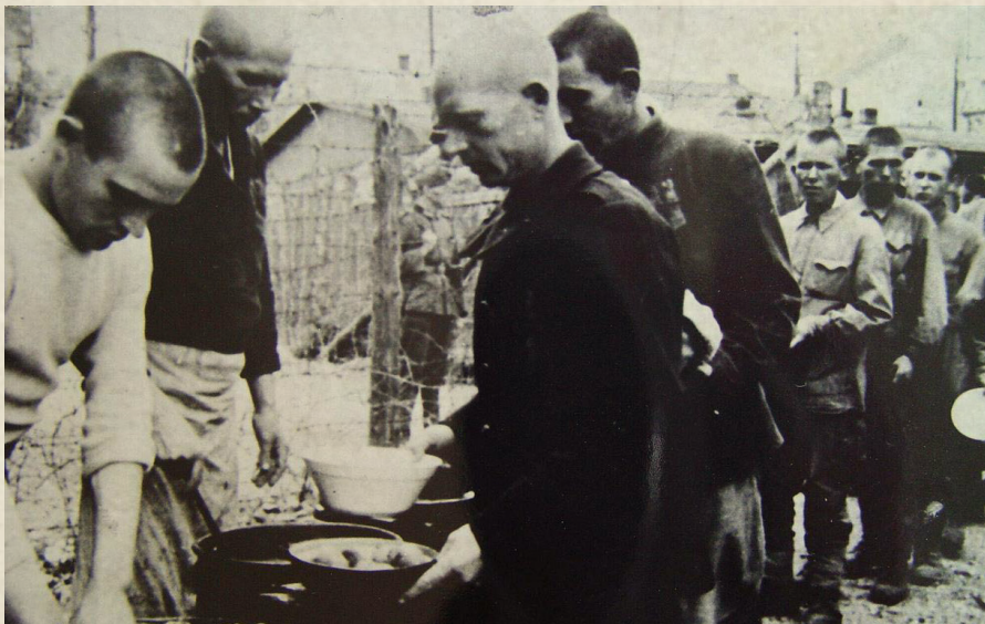
Na stavbě uhelných elektráren se podíleli totálně nasazení i zajatci z celé Evropy.
